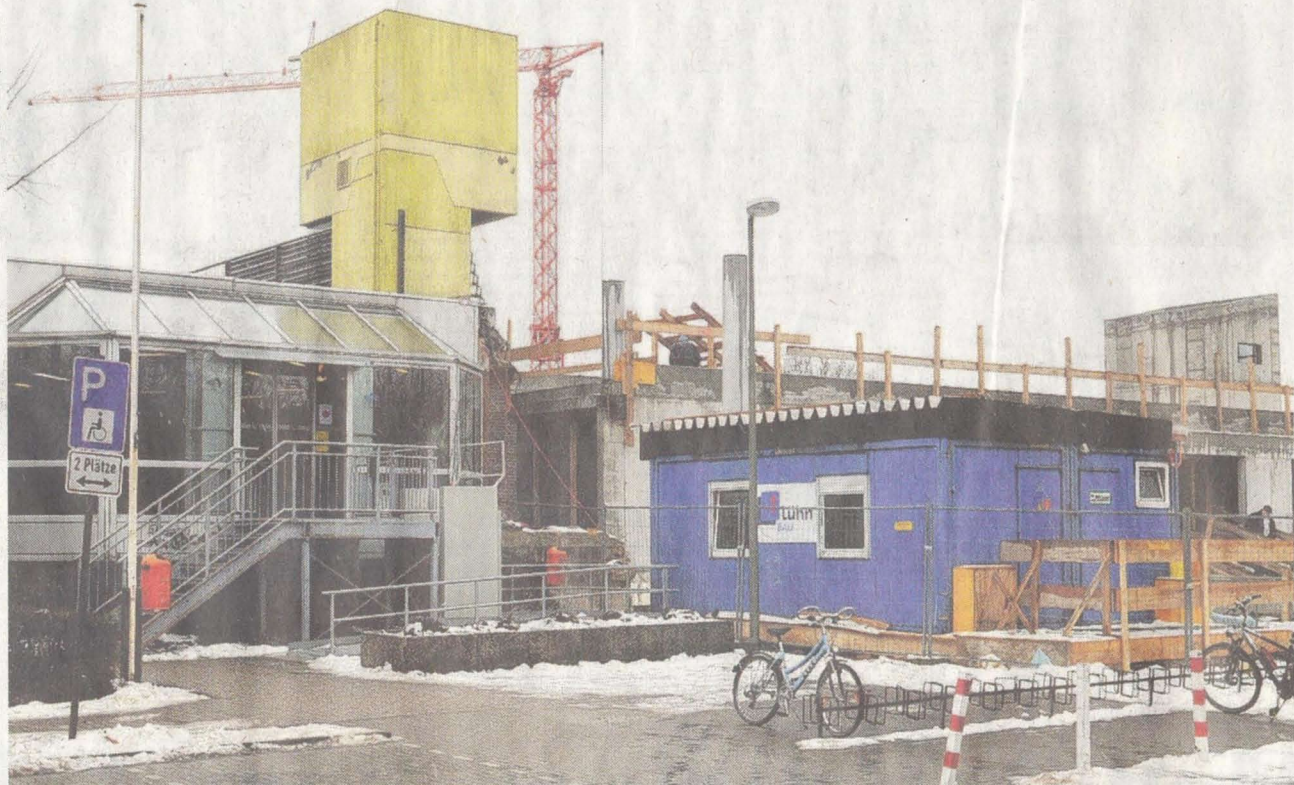
Äußerlich tut sich momentan nichts auf der Hallenbad-Baustelle, aber im Inneren geht es voran.
