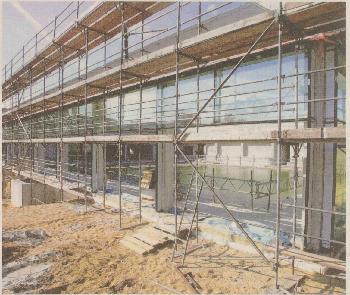
Die Arbeiten am neuen Dinslakener Bad – an Glasfassade, Technik, Schwimmbecken, etc. – liegen im Zeitplan. In der kommenden Woche soll das verschiebbare Dach angeliefert werden.
