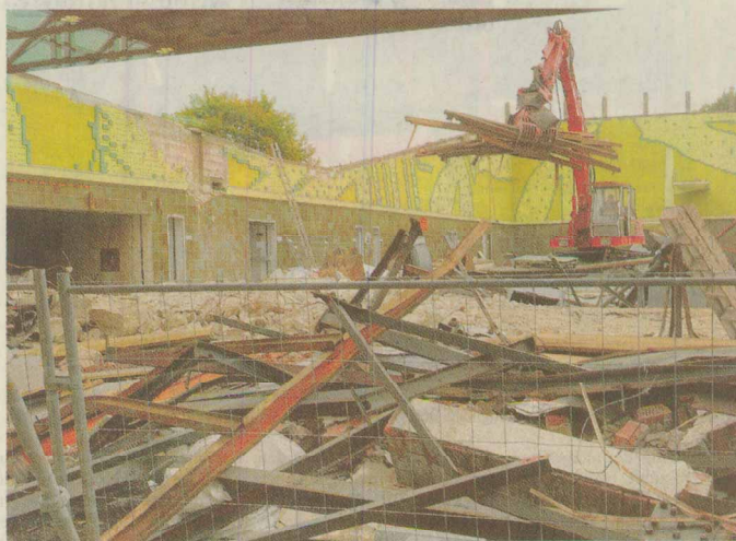
Beim Blick aus dem Fenster sieht man den Abriss des alten Volksparkbades.
